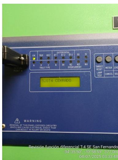
Ilustración 9: Estado interruptor 52BT4 previo Pulso a OUT102
