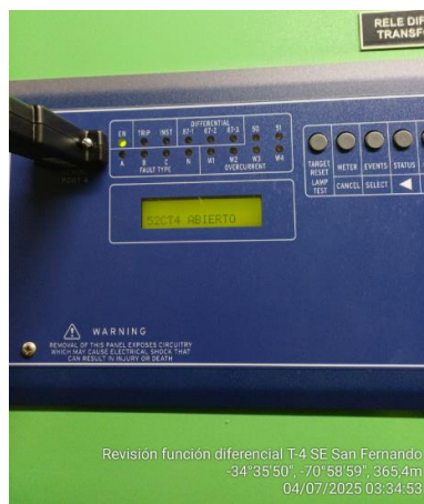
Ilustración 13: estado interruptor 52CT4 después de Pulso a OUT102
