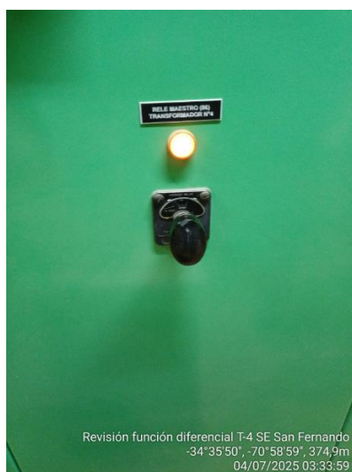
Ilustración 11: Estado relé maestro previo Pulso a OUT102
