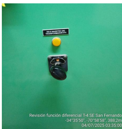
Ilustración 14: estado relé maestro después de Pulso a OUT102
